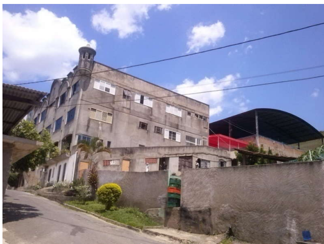
Fig. A.10 – Vista da Sede com terreno e quadra da escola. 166
