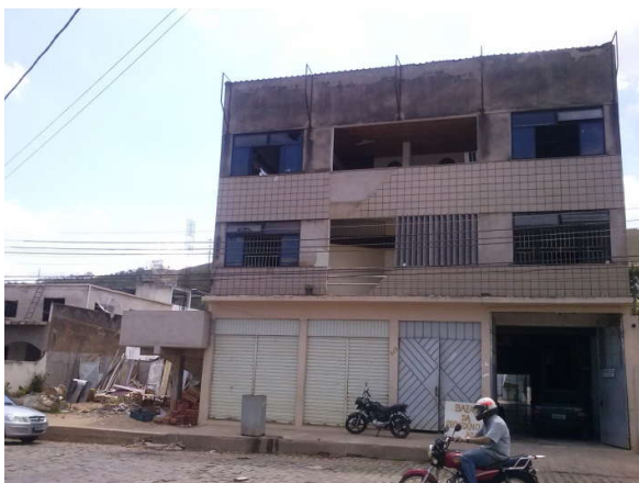
Fig. A.21 – Vista do prédio e terreno do lar dos deficientes. 177
